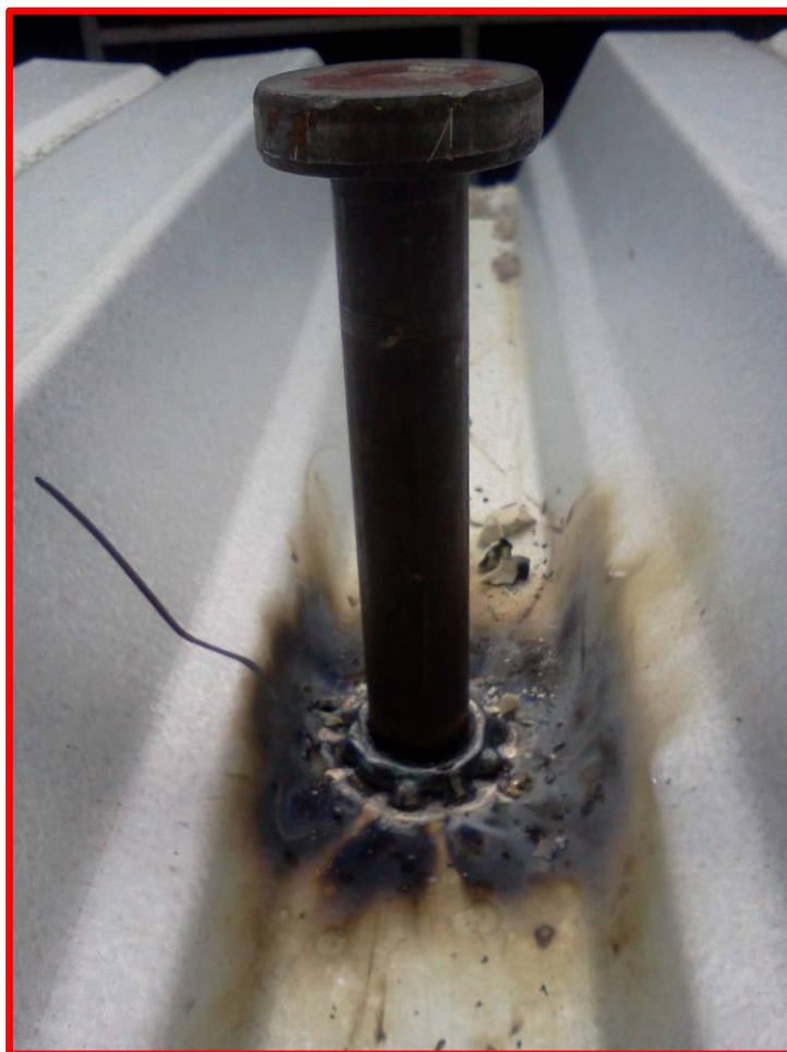
Svařování skrz plechy, SD 19 x 100 S235, prodloužení svařovací kabelace 20 m, svařovací pistole GD-22s, v podmínkách hraničících regulérností.
